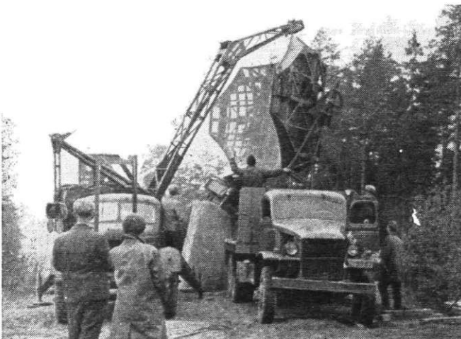
12. att. Antenas montāža Saules novērošanai.
