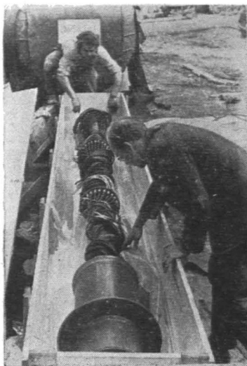
6. att. Polārās ass centrālais stienis ar kabeliem tubusa un deklināciju ass elektroierīču barošanai.
