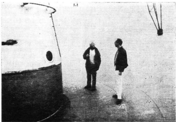
4. att. Zviedru profesori Rojs Būzs (pa kreisi) un Dainis Draviņš «pastaigājas» pa 32 m antenas spoguļi (atstarotā virsmu). Pa labi redzams viens no četriem sekundāra spoguļa balstiem, pa kreisi — fokālās kabīnes konuss. A. Balklava foto
