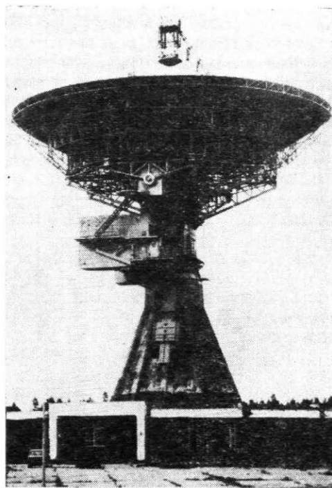
1. att. 32 m antenas kopskats
