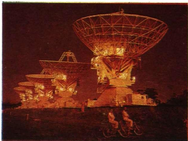
Piecas no sešām Austrālijas 6 km radiointerferometra antenām Narabrī tuvumā. Parabolisko, visos virzienos grozāmo antenu diametrs ir 22 m. Maksimālais radiointerferometra bāzes garums ir 6 km. Antenas pārvietojas pa īpaši aprīkotu sliežu ceļu. Nodots ekspluatācijā 1988. gada 2. septembrī
