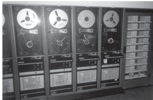
2. att. JIVE korelatora magnētisko lenšu datu nolasišanas iekārtas.
