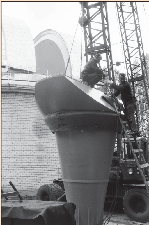
9. att. Samontēto stundu asi (jeb montējuma dakšas kātu) sagatavo iecelšanai kupola telpā.
